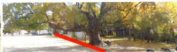
根元に接したU字溝
